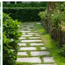
Pavés à joints enherbés
