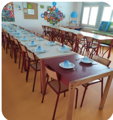
Réfection du sol de la cantine
