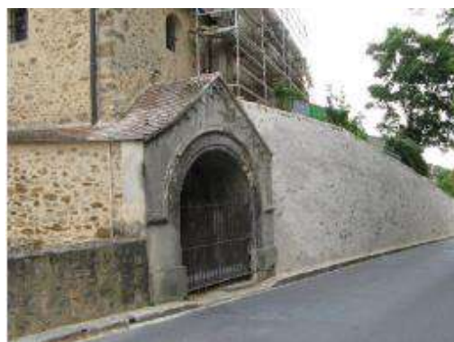
Porte d'accès de la crypte, en contrebas de l'église
