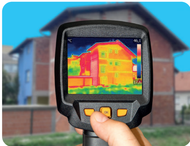
La caméra thermique permet de visualiser en direct les déperditions de chaleur d'un logement
