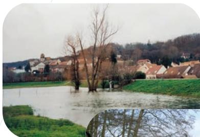
Bassin d'expansion de crue, assurant un stockage de l'eau et retardant son écoulement vers l'aval
