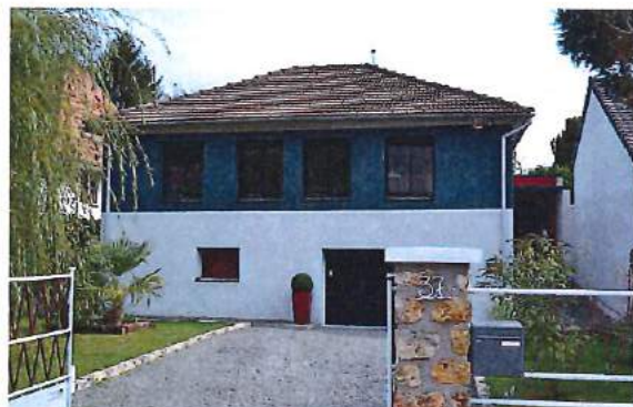
Rénovation d'un pavillon
