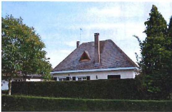
Toiture à quatre pans
