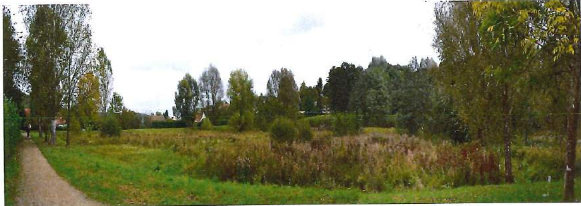
Zone humide du village - Bassin de retenue chemin des Sablons
