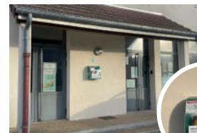
Gymnase de Vauhallan
