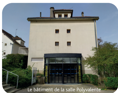
Le bâtiment de la salle Polyvalente
